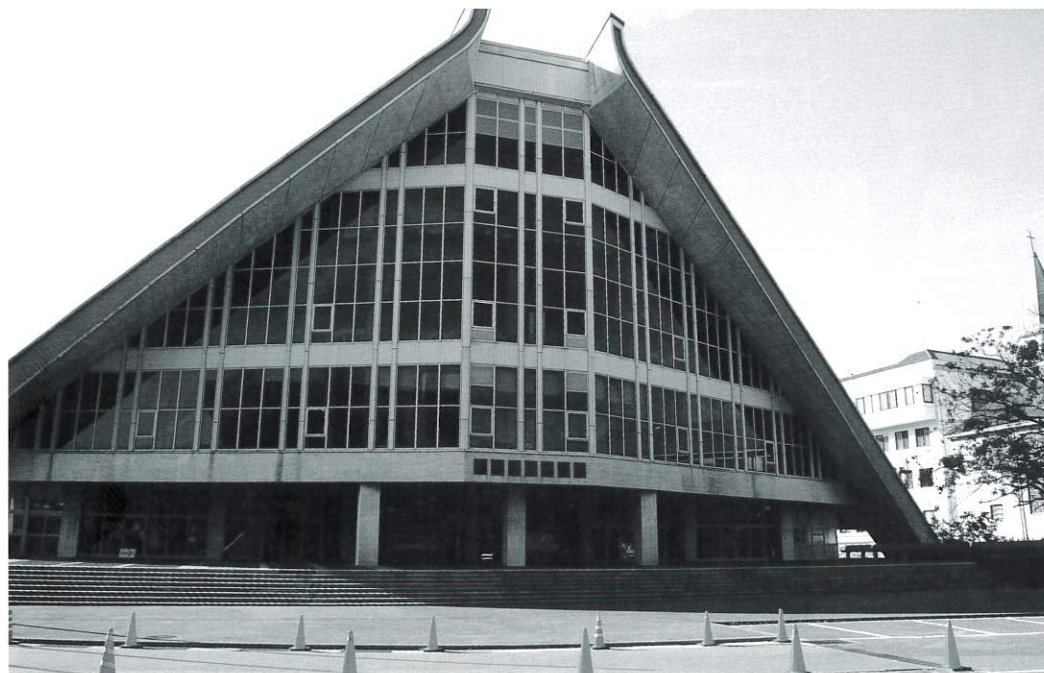
新総合体育館完成後に解体予定の下関市体育館(下関市向洋町)
